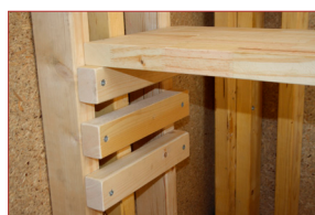
Détail des supports de réglages de hauteur des bancs © L. Lambert
