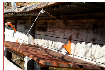
Détail du système d'ouverture des volets © J.F. Noblet
