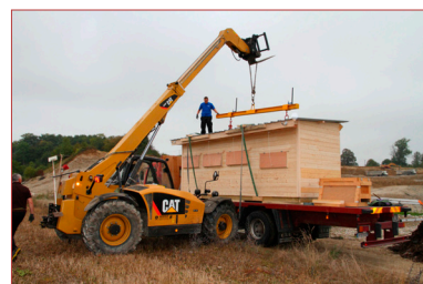
Installation du Grand Observatoire © J.F. Noblet
