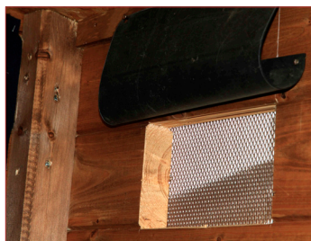
Aération du Grand Observatoire, Rives, Isère © J.F. Noblet
